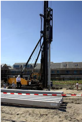
Fig. 5.1. Heiwerkzaamheden
