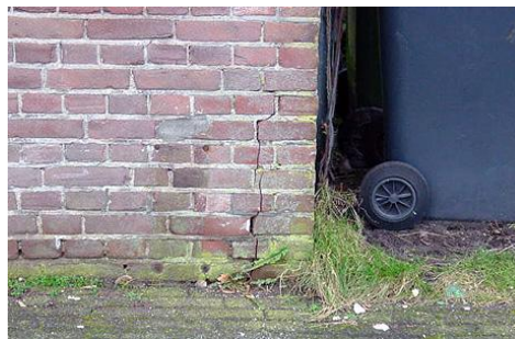
Fig. 3.1. Scheuren onderin het gebouw
