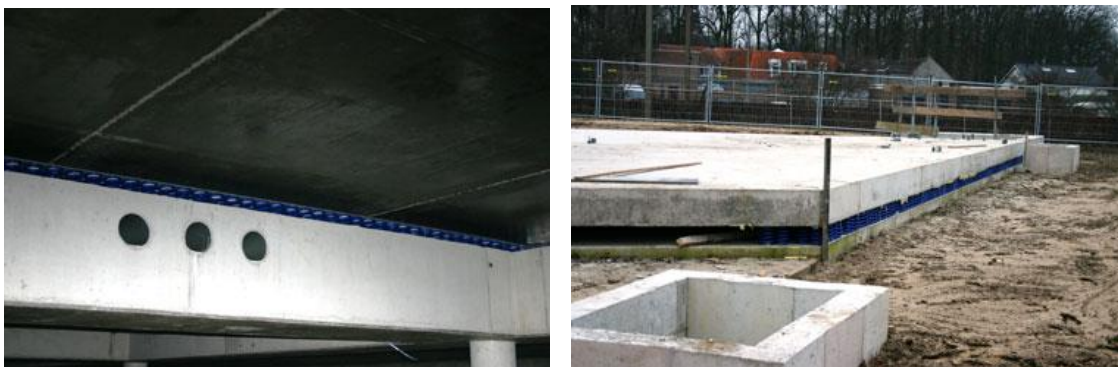
Fig. 5.1. Veren tussen de balken en vloerplaten.
