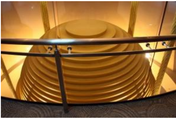
Fig. 5.12. Semi-actieve demper.
