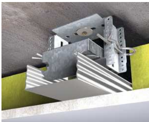
Figuur 6.14: Los houden van de spouwbladen. Links: verende bevestiging plafond aan vloer (Bron: Nevima); Rechts : gescheiden stijlen in een wand(Bron: Gyproc).
