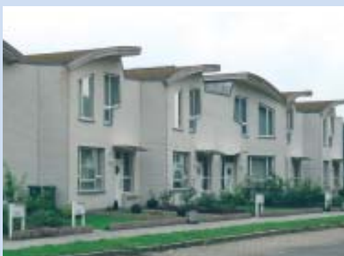
Bij sociale woningbouw speelt bewonersgedrag een grote rol bij de rendabiliteit van bepaalde maatregelen; sommige bewoners kleven nog steeds de ventilatieroosters dicht. Foto VIBE
