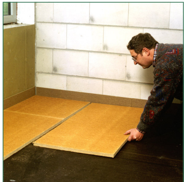
Als elastische of trillingsdempende laag kan je een houtvezelplaat gebruiken. Bron: Gutex
