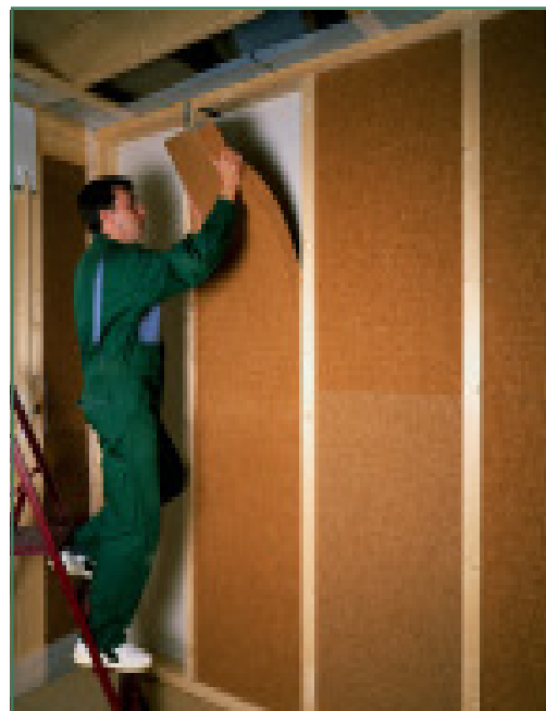
Een voorzetwand geïsoleerd met houtvezelplaten. Bron: Homatherm
