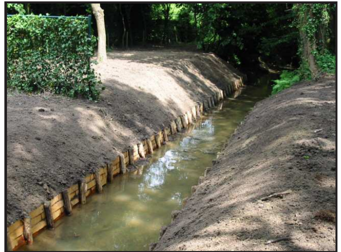
Betuining in het Hulstenbeekje te Zoersel. Paaltjes en matten in FSC-gelabeld robinia.
