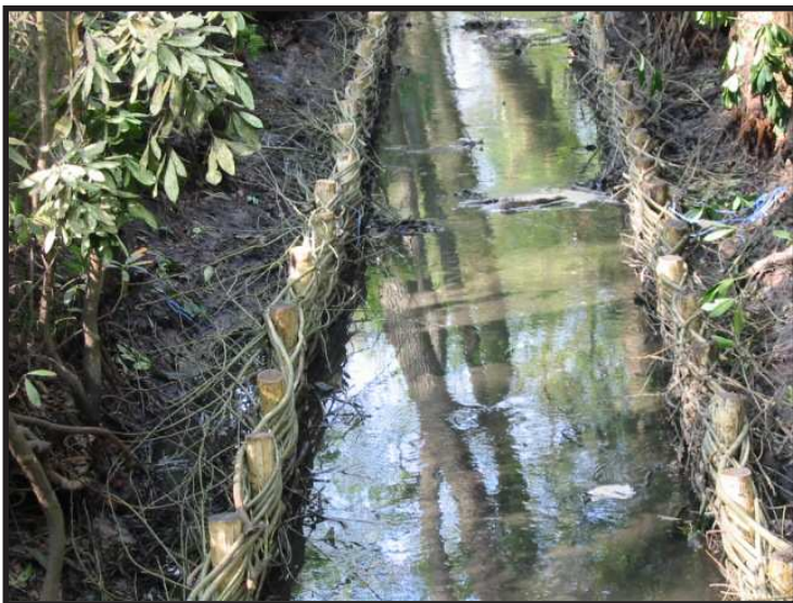
Overbeschoeiing koningeloop Oud-Turnhout. Paaltjes en matten in FSC-gelabeld robinia.
