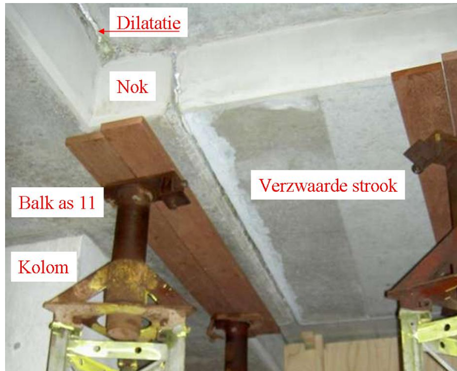
Foto 2.5: Overzicht nok aan balk op as 11.
