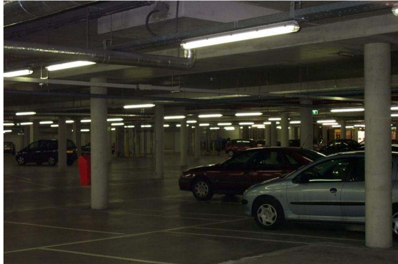
Foto 2.3: Overzicht bovenste parkeerlaag.
