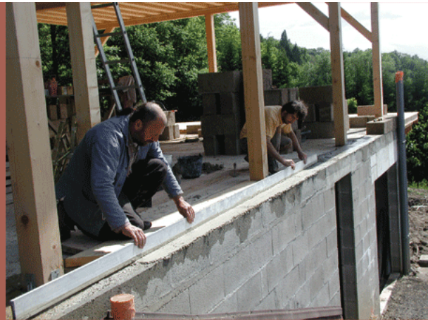
Dressage du support maçonnerie pour la pose du premier rang de Chanvribloc.
