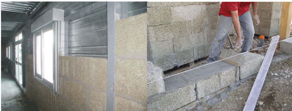
Isolation complémentaire en Chanvriblocs d'un bardage double peau métallique : construction d'un bâtiment industriel
