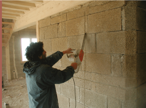
Rainurage à la tronçonneuse d'une cloison en Chanvriblocs pour intégration des réseaux électriques
