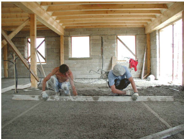
Pose d'une dalle de chanvre sur hérisson de galet
