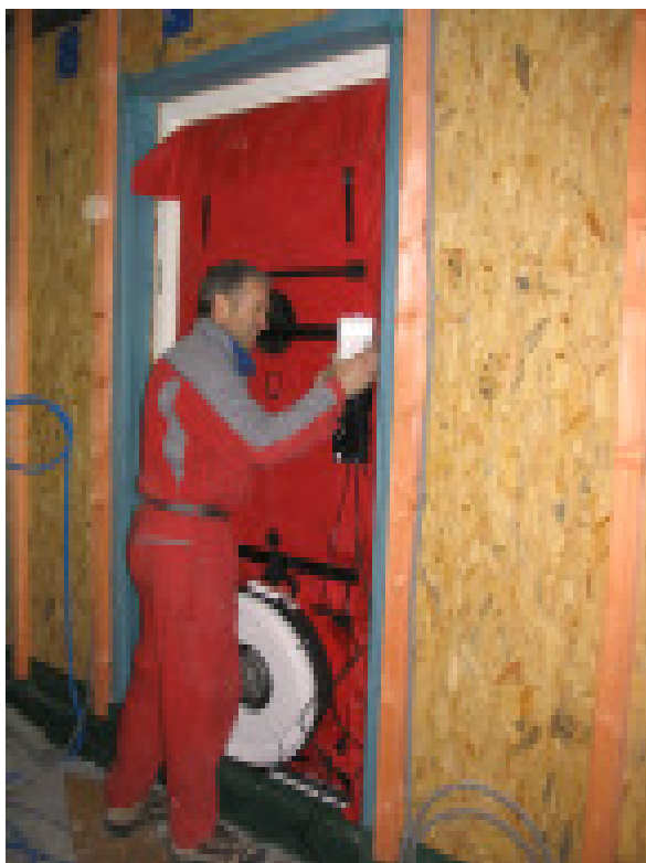
Je kunt de luchtdichtheid controleren met een Blower Door test. Bron: Guy Jaenen
