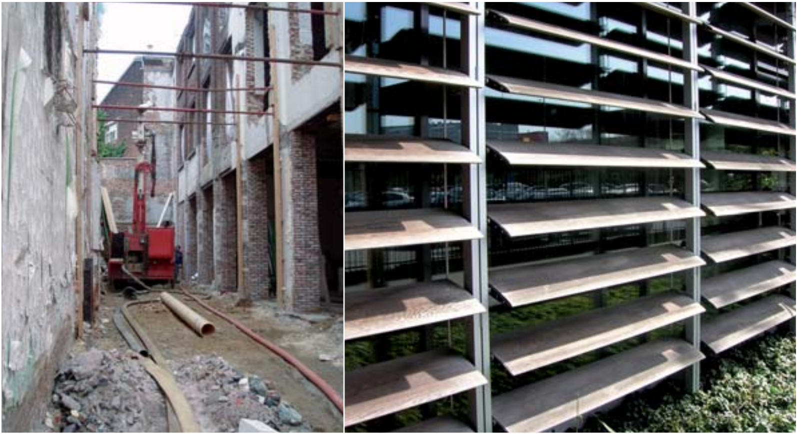
We lieten twee boringen uitvoeren voor onze warmtepomp, die de warmte van het grondwater benut (Foto: Jenny Dedoncker). De houten lamellen aan de voorgevel en boven aan het atrium houden de zon buiten in de zomer. (Foto: Ruud Leijser)
