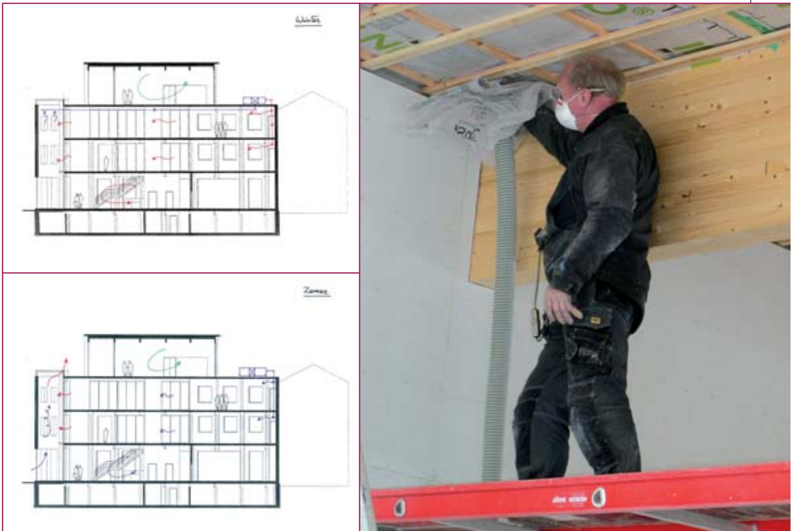
Het houten dakgebouw is geïsoleerd met papiervlokken die in het dak en de wanden werden geblazen. (Foto: Jenny Dedoncker). Op de tekeningen zie je de ventilatiestromen. Blauw is koud, rood is warm. (Tekeningen: IRS Studiebureau ir. B. Depré)
