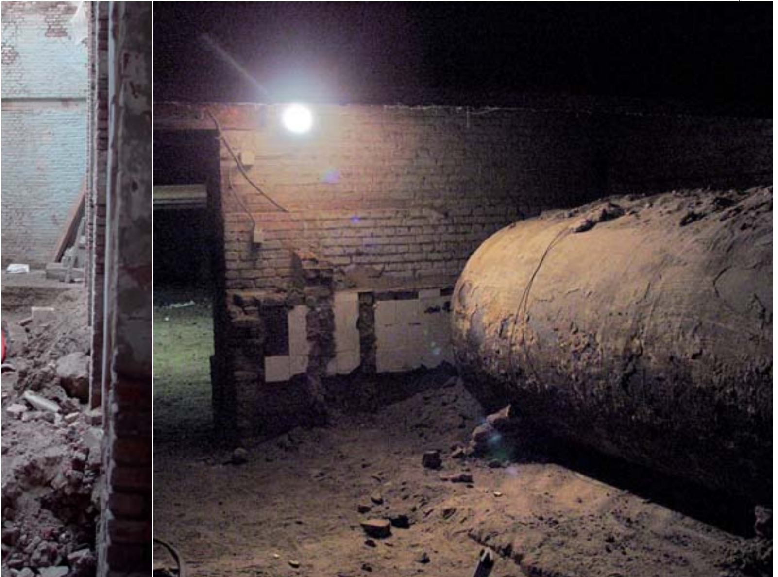
De oude septische put werd gereinigd en omgebouwd tot regenwaterput. De oude mazouttanks werden uitgespoeld en gevuld met zand. (foto's: Jenny Dedoncker)
