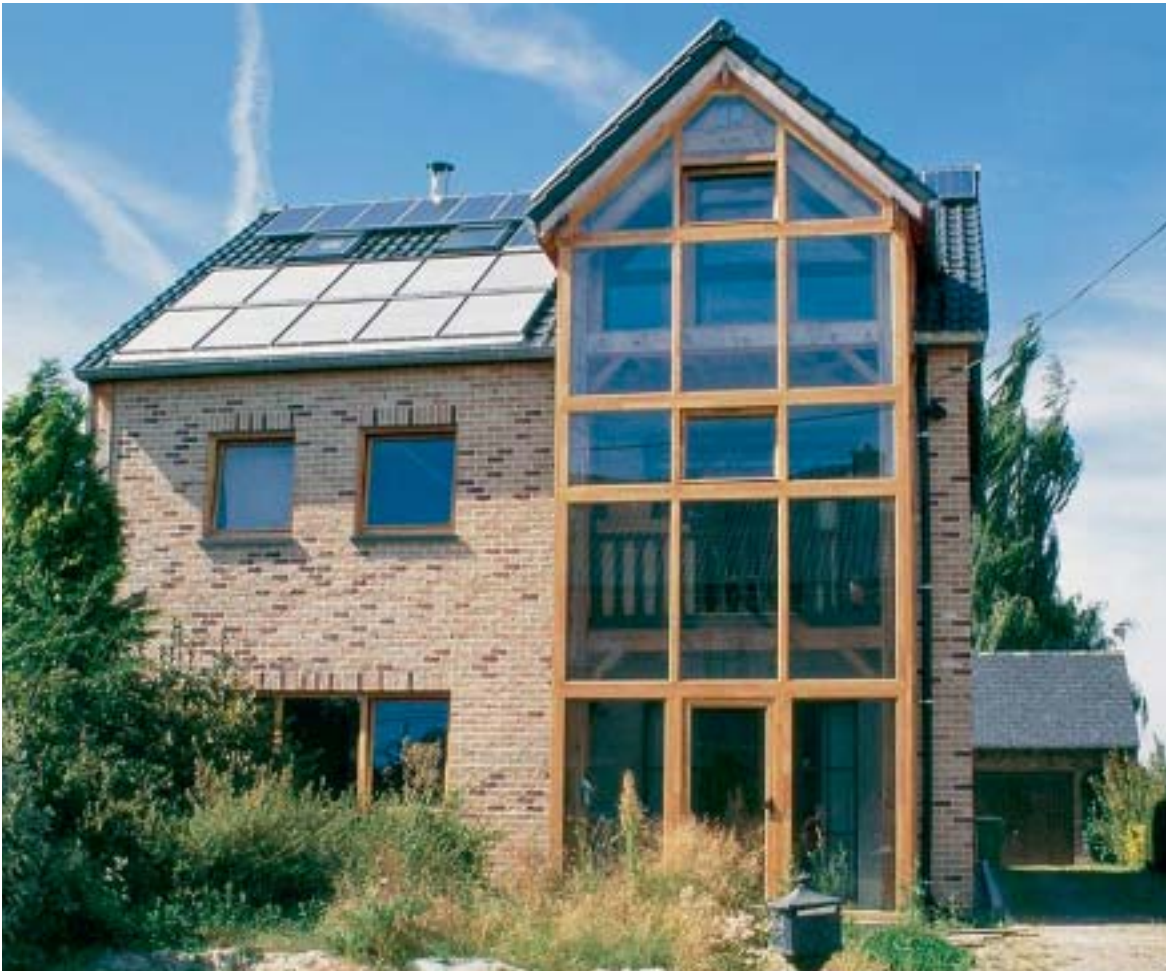
Bio-ecologisch laagenergiehuis met fotovoltaïsche en thermische zonnepanelen. Architect Marij Gabriëls.
