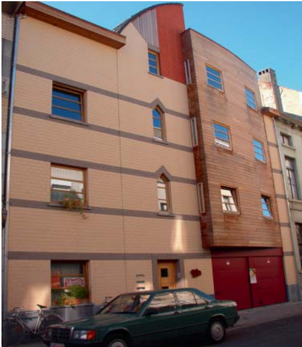
'Een bio-ecologisch gebouw is bij voorkeur gelegen in de stads- of dorpskern'. Architect Herman Remes.
