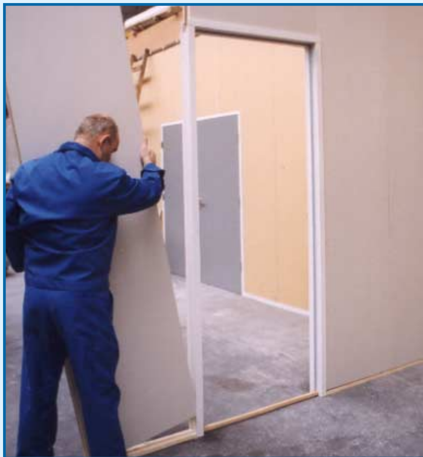
Kozijn kan met eenvoudig timmermansgereedschap in de wand worden geïntegreerd.
