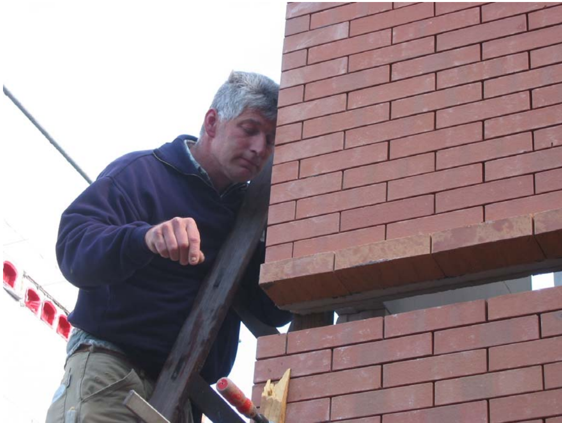
Figuur 3: montage verdiepingselement
