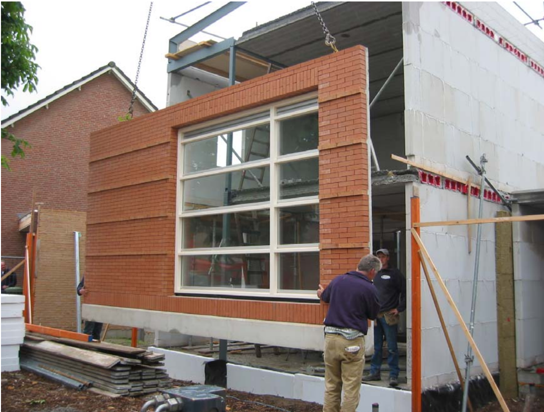
Figuur 2: gevelsluitend en winddragend baksteen element
