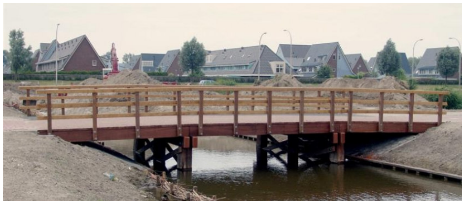
Fig. 3 Houten brug Groene Loper Noord, buitenplaats Ypenburg ( www.meerdinkbruggen.nl )
