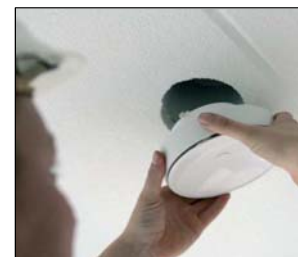
Ventilatiesparingen al fabrieksmatig aangebracht
